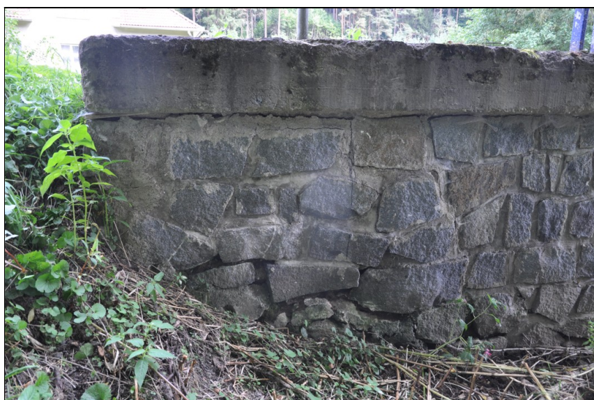
Konec dlouhého rovnoběžného křídla vlevo je narušen a opravován.
