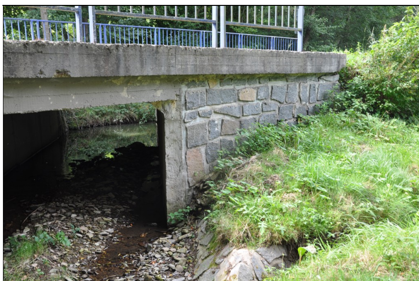
Křídlo u opěry 2 vpravo.
