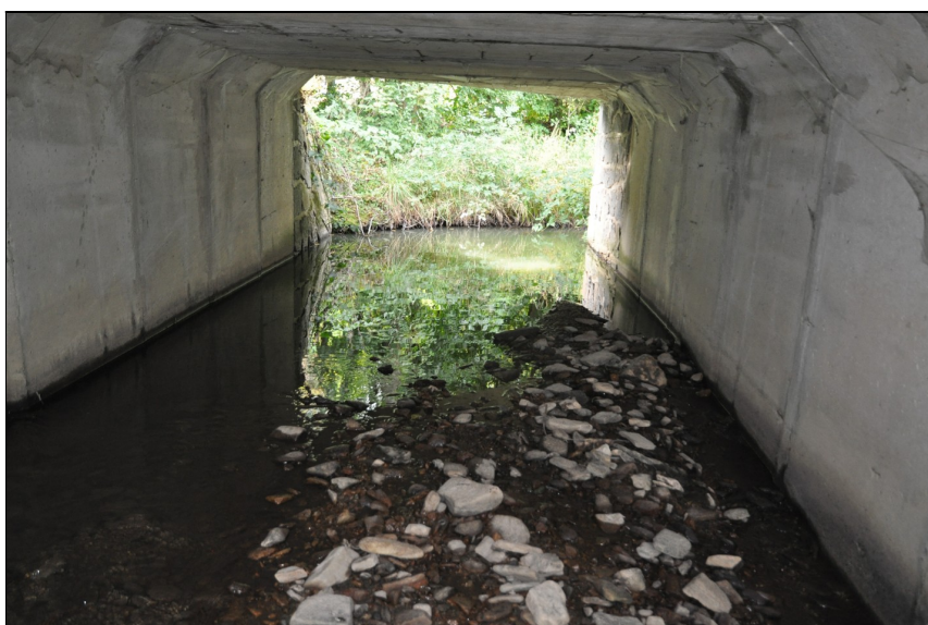
Nánosy štěrku ve dně vpravo je nutné odtěžit.
