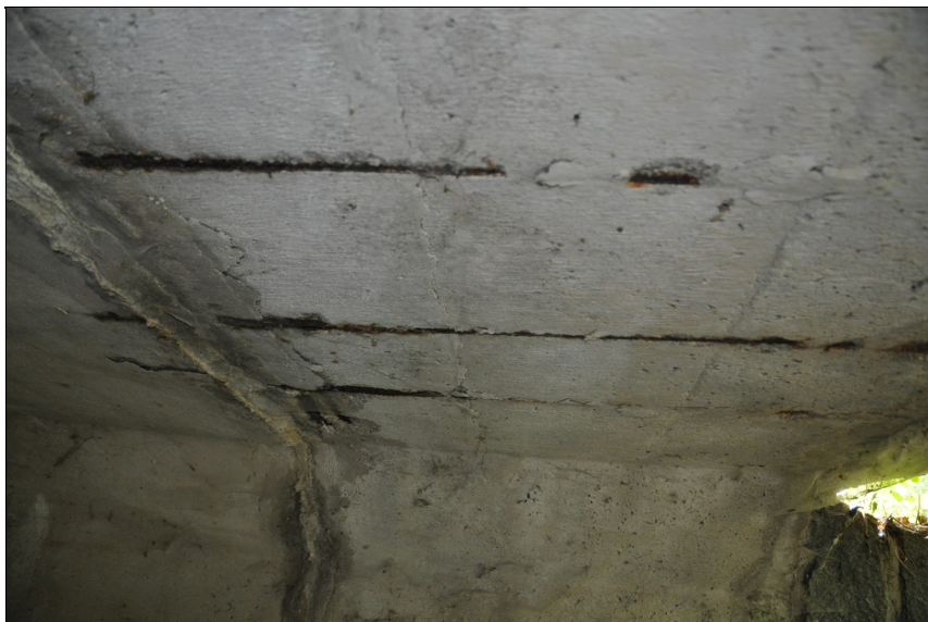
Obnažená korodující výztuž v podhledu nosné konstrukce vlevo.
