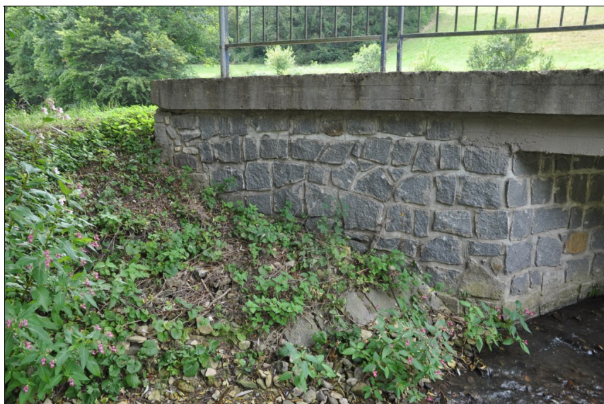
Křídlo u opěry 1 vpravo.
