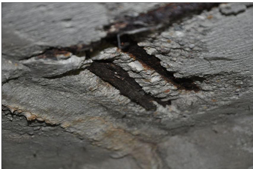
Detail z předchozí fotky. Výztuž v krajním rámu vlevo je korozí oslabena.
