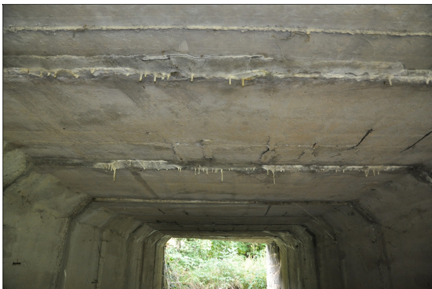
Zvodnělé spáry mezi rámy v podhledu nosné konstrukce vpravo.
