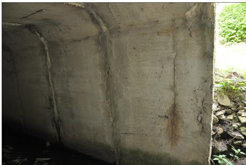
Zvodnělé spáry mezi rámy.
